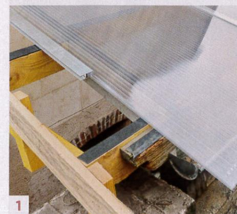
**MATÉRIAUX.** Poutres de support en pin à peindre • Panneaux « Onduclair » PCMW 16 mm, 17 €/m<sup>2</sup> environ, Onduline • Profilés en aluminium de jonction • Embouts de profilés en aluminium • Bandes d'isolation pour extérieur • Vis.
